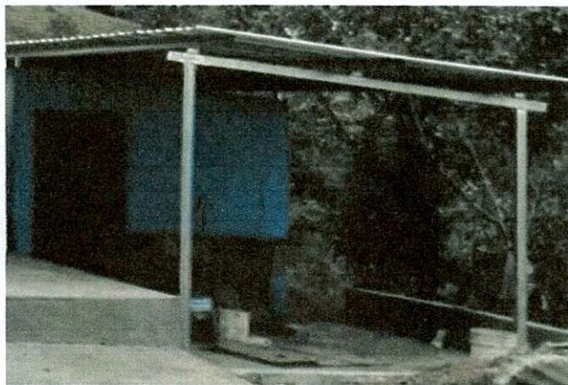
Foto 1: Mejoramiento de cocina, cambio de puerta de estructura de madera a metal, y cubierta de lámina troquelada calibre 26, cambio de pilares de estructura de madera a metal del corredor cubierta de lámina troquelada calibre 26
